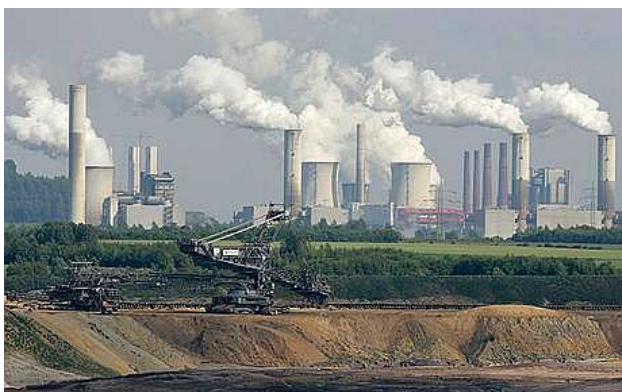
Obr. 229: Uhlerná elektrárna Zdroj: econews.com.au
